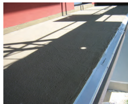
Aplikovaná cementová stierková hydroizolácia PCI Seccoral®
