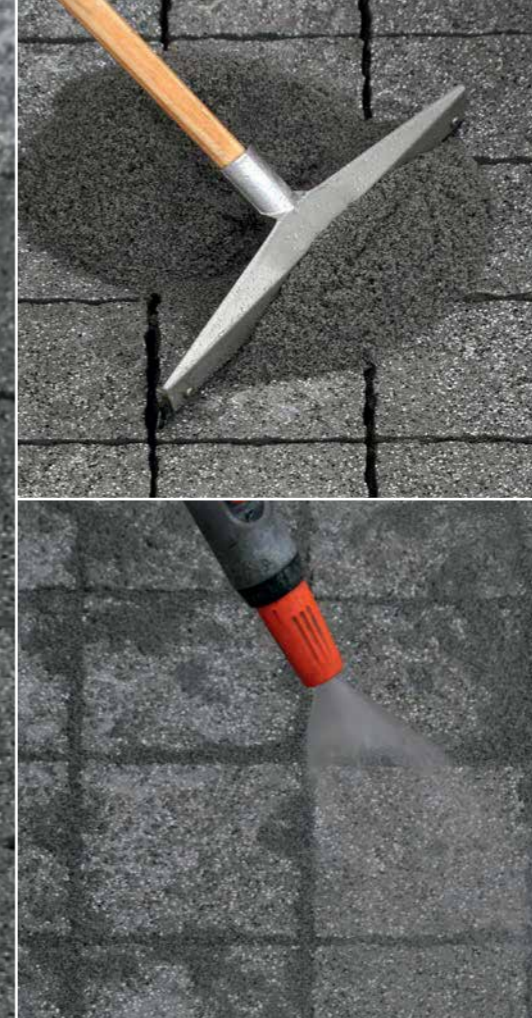
Materiál dôkladne zapracujte do škár. Dodržujte minimálnu veľkosť škár! Podklad udržiavajte vlhký.
