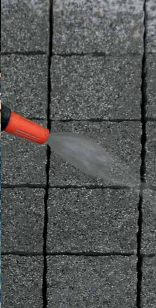
Pred použitím PCI Pavifix 1K Extra plochu riadne navlhčíte.
