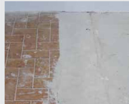
Rôzne typy podkladov v jednej miestnosti predstavujú veľké riziko vzniku trhlín vzhľadom k rôznym vlastnostiam podkladov. Hrozí tu riziko rozdielného pnutia.
