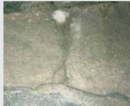
Vyplnené miesta v poteroch , napr. v prípade vybúrání priečok alebo okolo dverí. Je tu veľké riziko vzniku trhlín v miestach napojenia. Bežne je nutné toto napojenie riešiť dodatočne pomocou „zošívania“ so živcami.
